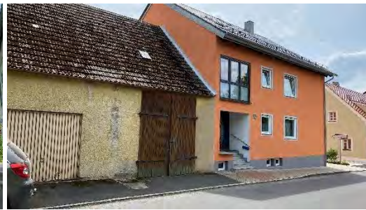
Saniertes EFH, Blumenstraße, Plössberg
