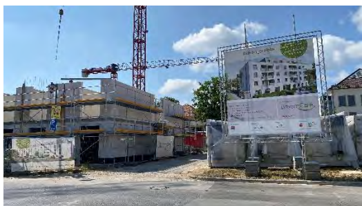
Baugebiet Köferinger Höhe, Amberg
