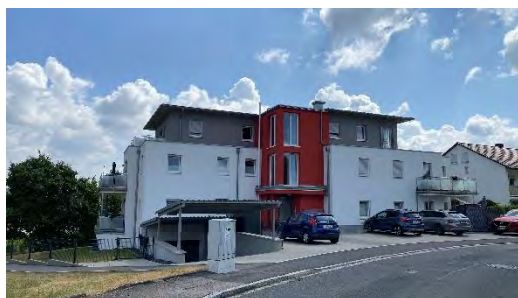
MFH-Neubau, Hörmannstraße, Amberg
