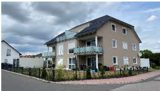
Neubau MFH, Tonweg, Stulln
