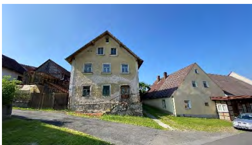
Sanierungsstau, Hauergasse, Waldthurn
