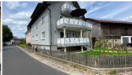
Saniertes MHF, Alte Schulstraße, Plössberg
