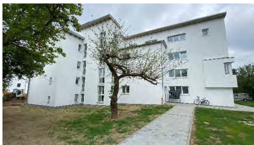
Neubau am Krankenhaus, Tirschenreuth
