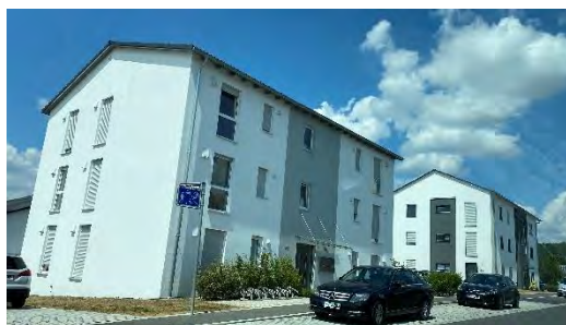
Baugebiet Drillingsfeld (MFH), Amberg
