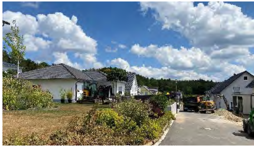
Neubau EFH, J-Baptis-Pöhnlein-Straße, Illschwang
